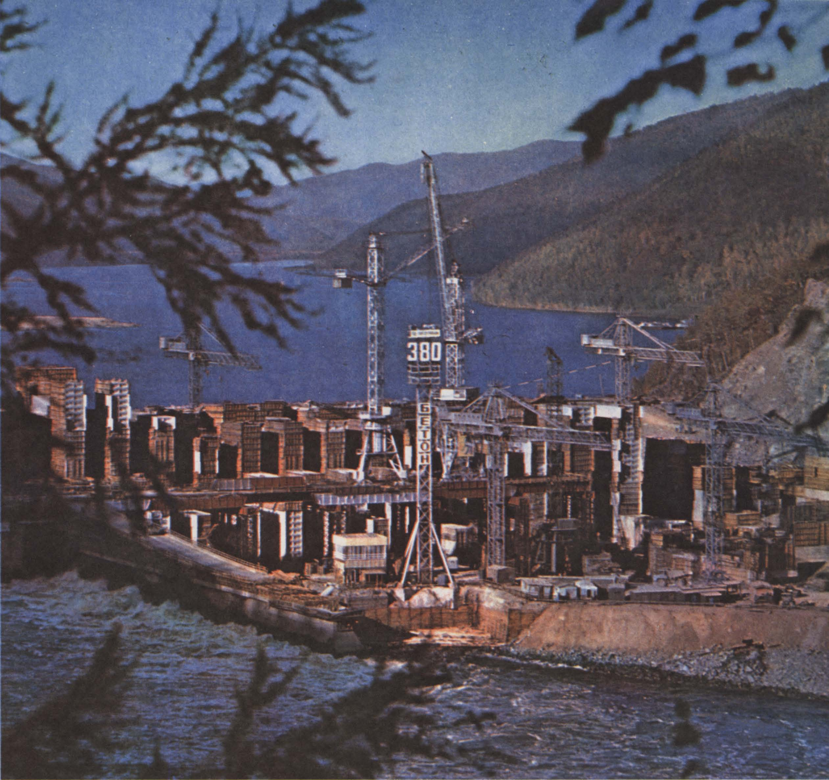
Нет на Зее места красивее Серебряного створа. Здесь выросла плотина ГЭС.
